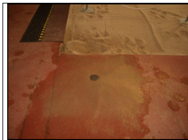
Verschluss des Kernbohrlochs mit Kaltasphalt
